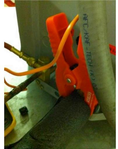
La temperatura de saturación del conducto de succión indica aproximadamente 44 °F (6,7 °C) en el medidor. La temperatura de la superficie del conducto de líquido indica 54,1 °F (12,2 °C). La temperatura de la superficie refleja la temperatura real del refrigerante. Para calcular el recalentamiento, reste a la temperatura de la superficie la temperatura del medidor:
