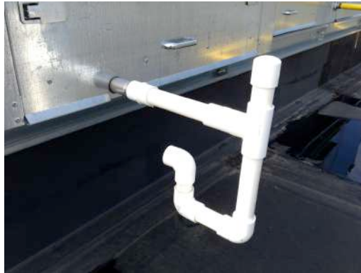
Sifón típico de serpentín de refrigeración
